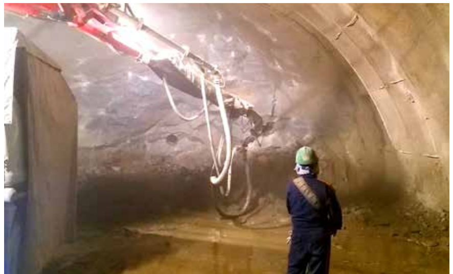
Công tác bê tông phun
